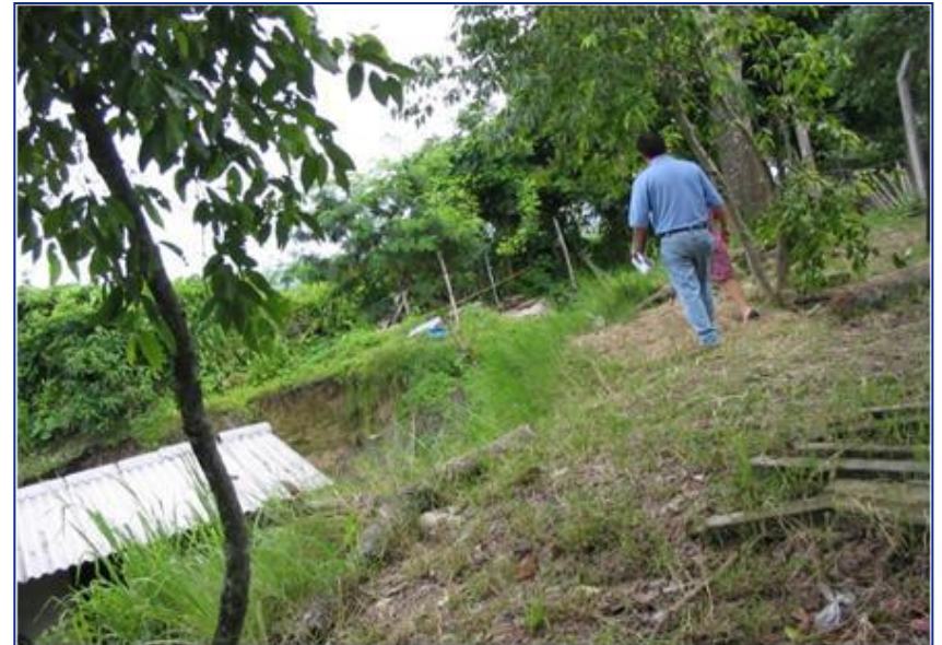
SE CONSTRUIRA MURO Y CERCA DERRIBADA POR TORMENTAS.
