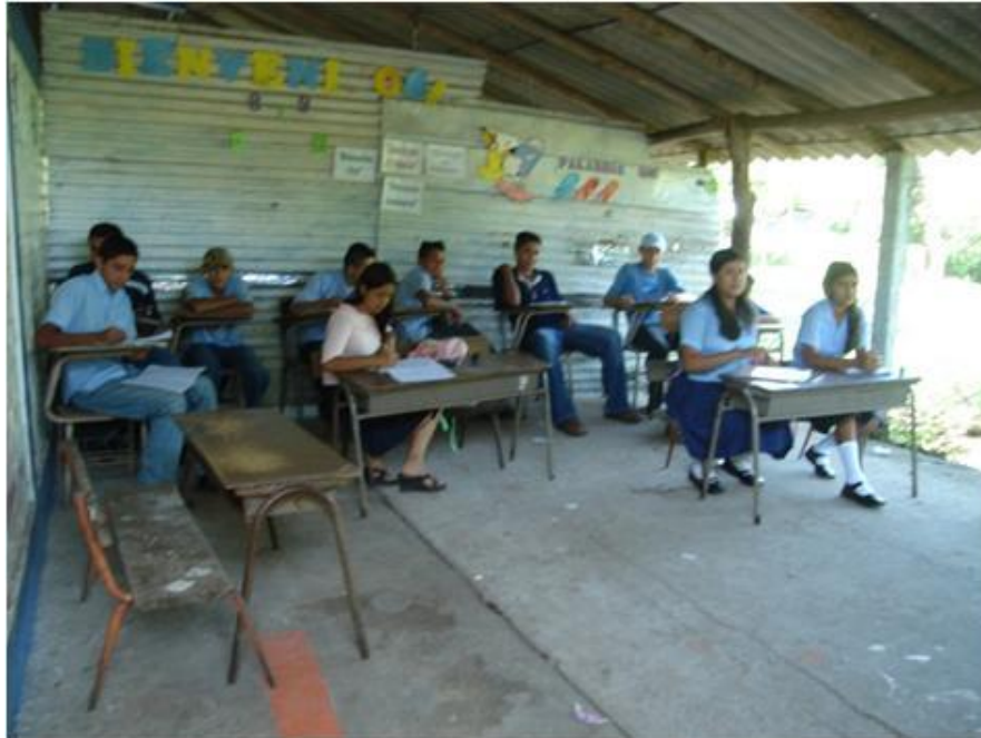
MODULOS DE AULAS PROVISIONALES A SUSTITUIR
