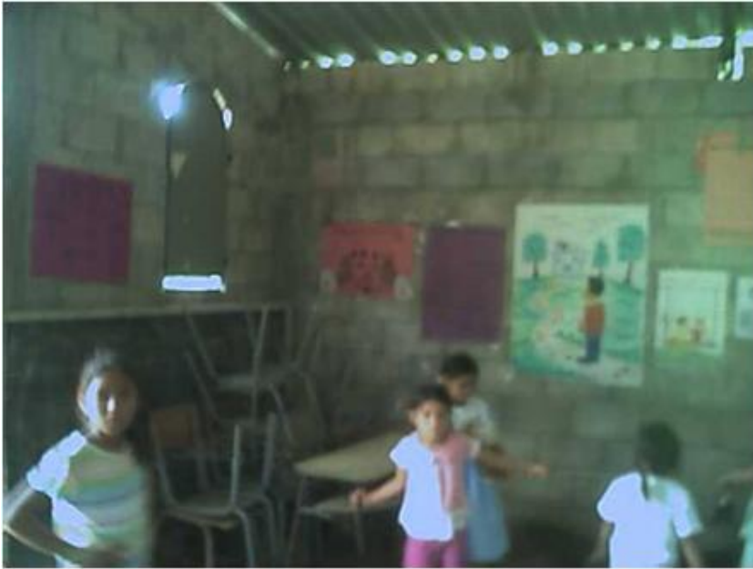
CONDICIONES INICIALES DE LAS AULAS
